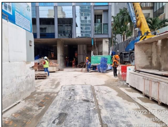
รูปที่ 2-16 แผ่นเหล็กปูพื้น (Platform)
