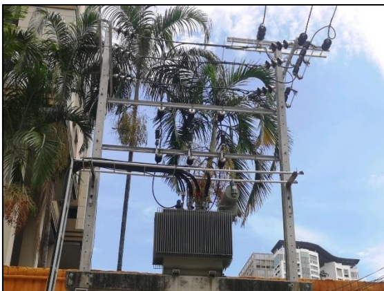
รูปที่ 2-38 หม้อแปลงไฟฟ้า และแผงควบคุมวงจรไฟฟ้า
