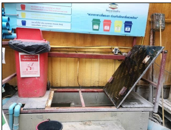
รูปที่ 2-24 บ่อดักขยะ และบ่opakน้ำทิ้ง
